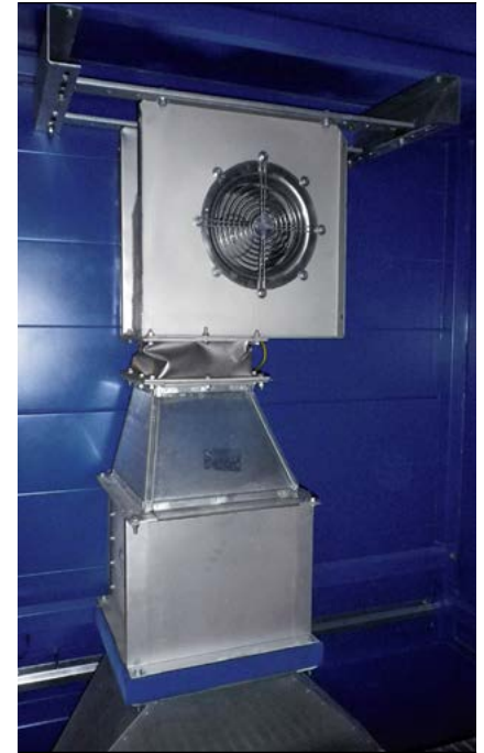
Elektro-Umluftheizung mit digitaler Temperaturregelung
