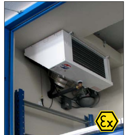
Split-Kühlaggregat (Innenansicht) in explosionsgeschützter Ausführung.
