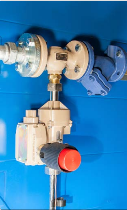
Dampfheizung mit Temperaturregelung, mechanisch ohne Hilfsenergie
