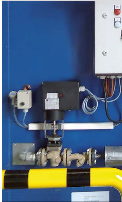
Dampfheizung mit Temperaturregelung, elektrisch
